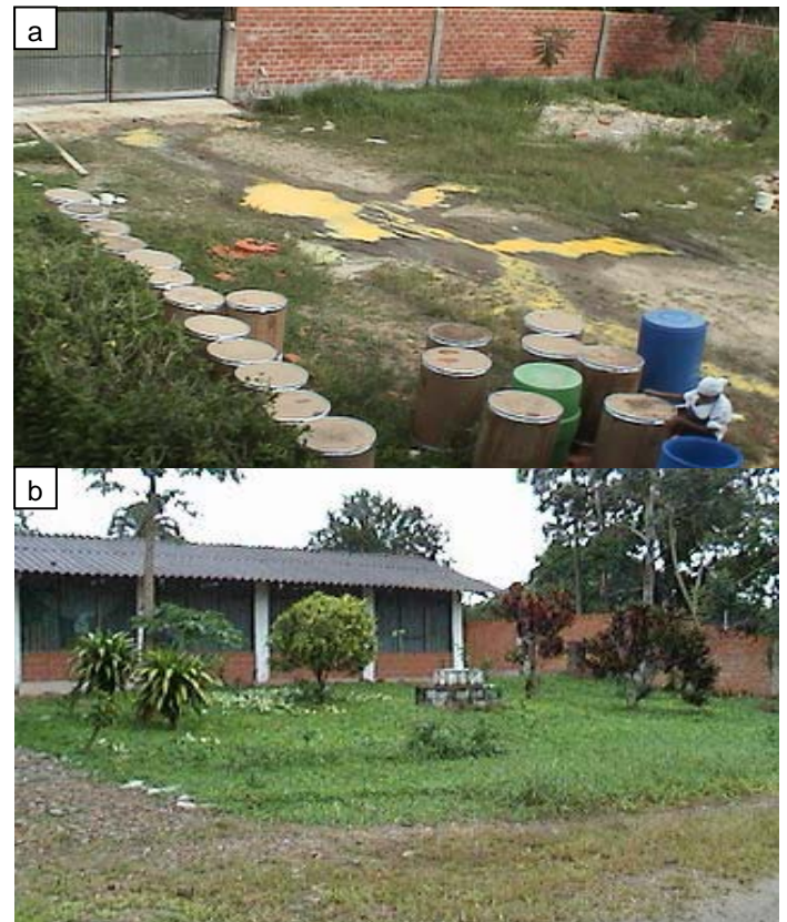
Figura 2. Vista general de la planta: a) Año 2003; b) Año 2005.
