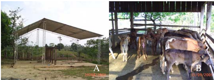
Figura 3. Salas de ordeño A) Vista de la estructura de la sala de ordeño B) Vista del cepo y comedero al interior de la sala de ordeño.
