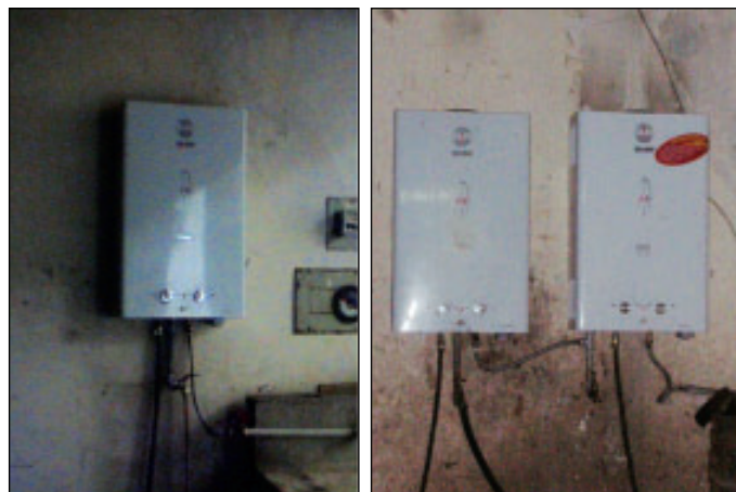
Figura 5 Izqda. Antes se tenía un solo calentador y se trabajaba a 60 °C para teñido y engrase. Der. Actualmente, se tiene 2 calentadores para trabajar a 80°C.
